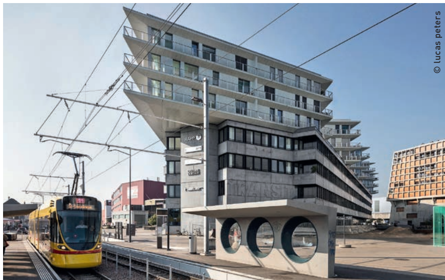
«Blitzbau»: Nach dem Umbau bietet das Transitlager circa 22.000 Quadratmeter BGF.
